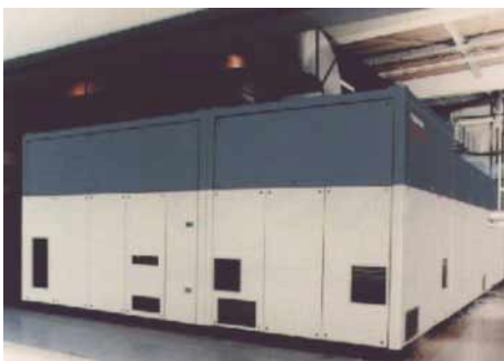
1.2-2：1MW級常圧型PAFCプラント（港区）
