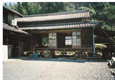
5-8：家屋復旧工事の例2
