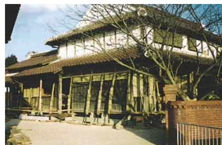
5-7：家屋復旧工事の例1
