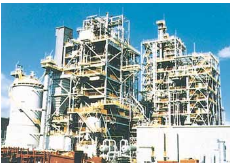
1.4-11：200t/日 IGCC パイロットプラント
