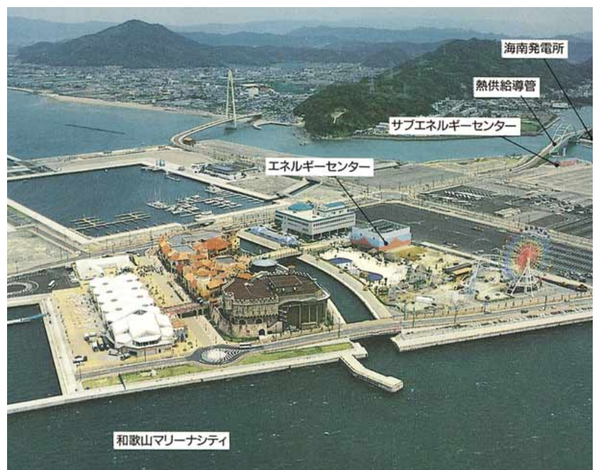
1.7-6：環境調和型エネルギーコミュニティ事業 和歌山マリーナシティ熱供給システム（和歌山市）
