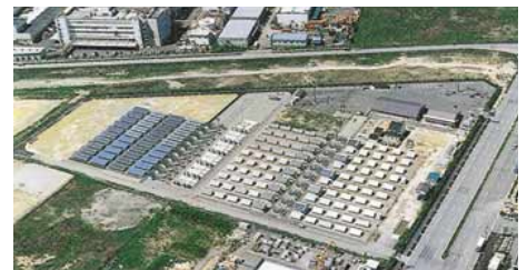
1.7-3：六甲新エネルギー実験センター
