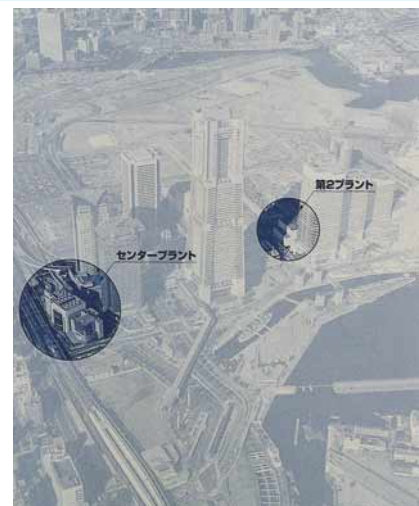
1.7-16：みなとみらい121地区の外観
