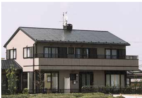
1.1-11：屋根に新建材一体型太陽電池モジュールを使用した例
