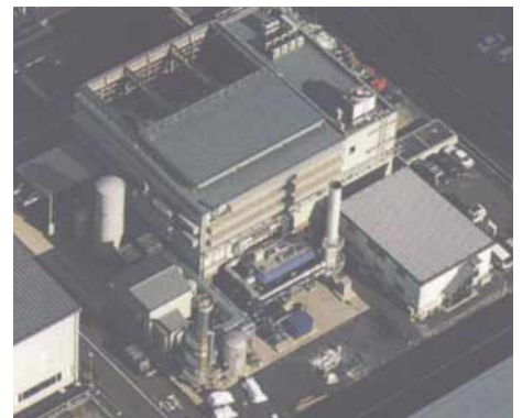
1.2-12 : 1,000kW級MCFC発電プラント (川越)
