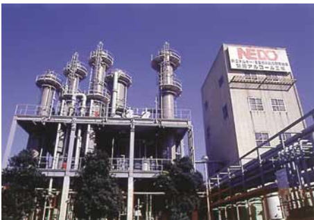
6-3：国営工場の建設
