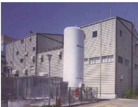
1.2-3：5MW級加圧型PAFCプラント（尼崎）
