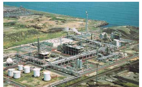
1.4-4：瀝青炭液化パイロットプラント(150t/日)の全景
