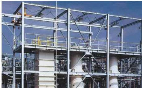
1.6-55 : フラッシュ発酵パイロットプラント
