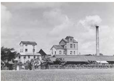
6-4：操業を開始した国営工場
