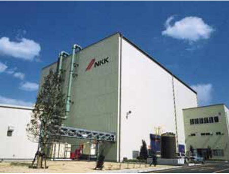
1.7-17：廃プラスチック高炉原料化設備
