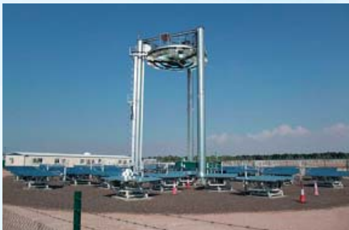
ビームダウン型太陽熱発電システム(アブダビ実証試験サイト)
