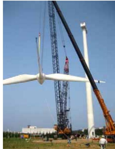
図 4.2.5-6 ブレードの上架
