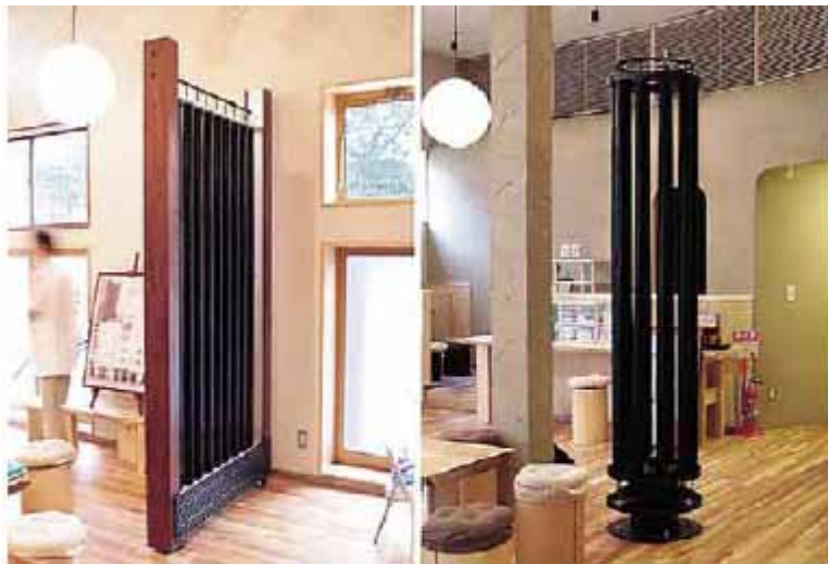
輻射式冷暖房装置ハイブリッドサーモシステム ecowin (エコファクトリー)
