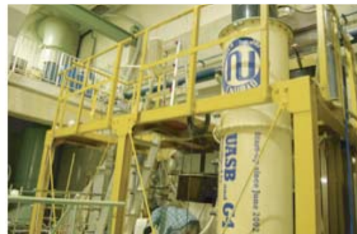
長岡中央浄化センターに設置されたUASBリアクター
