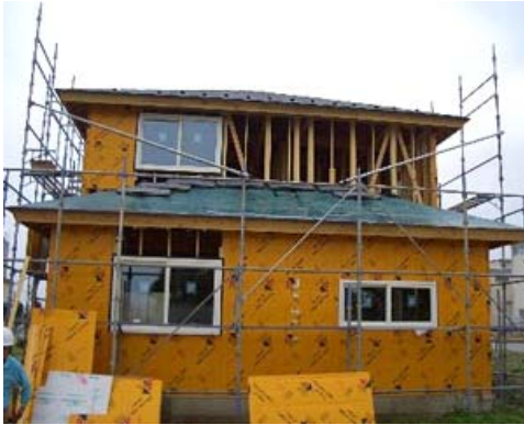
ハイブリッド断熱ボード施工風景
