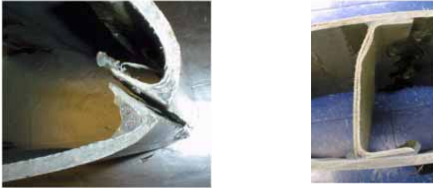
図7.34 ブレードの小中規模損傷の例
