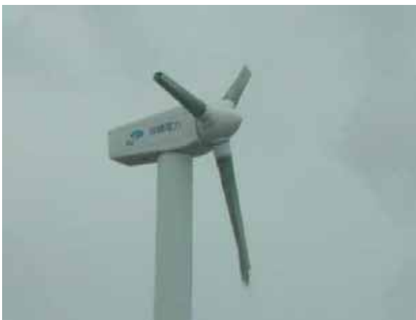
図7.1 台風0314号によるブレード被害
