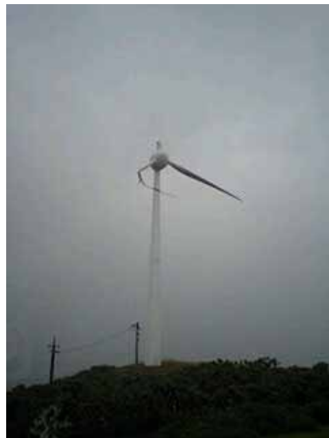
図7.2 台風0715号によるブレード被害
