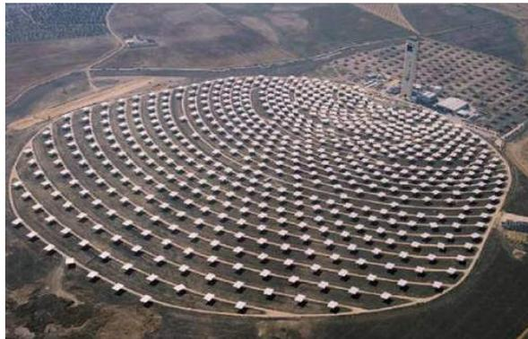
(タワー高さ 115m、フィールド面積約 75,000m<sup>2</sup>)
