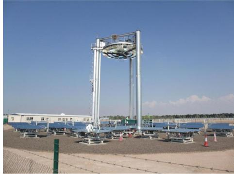
ビームダウン型太陽熱発電システムは、タワー中央に集められた太陽光を、中央反射鏡で地上に設置した溶融塩レシーバに集光し、蒸気を生成して発電する。
