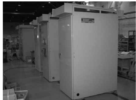
図2 実証機コンバータ盤、分電盤、計測盤
