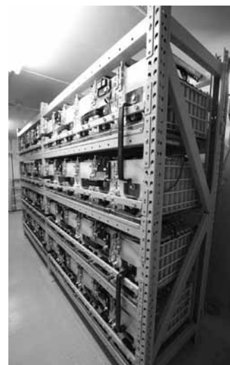
図 4 実証機モジュール設置状況
