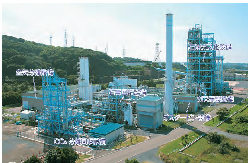
図6：EAGLEパイロット試験設備外観
