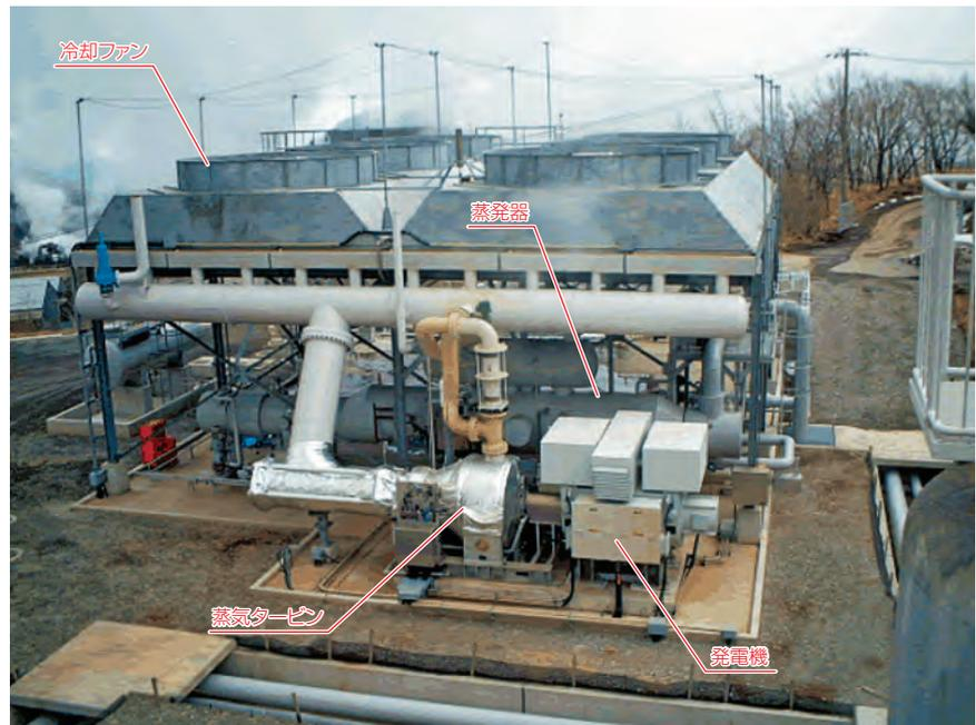
(注1)バイナリー発電は、沸点の低い媒体(ペンタン、アンモニア)を使用してタービンを駆動することにより、蒸気発電方式では利用できなかった低い温度域の熱水による発電を行う。バイナリー発電方式は「新エネルギー利用等の促進に関する特別措置法施行令」において新エネルギー利用の一つとして整理されている。
