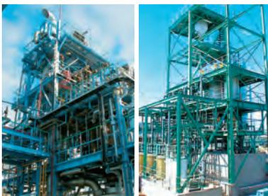
図12：液中燃焼法によるフロン等処理設備
