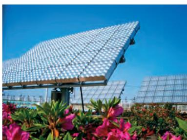
図5：集光型太陽光発電システム
