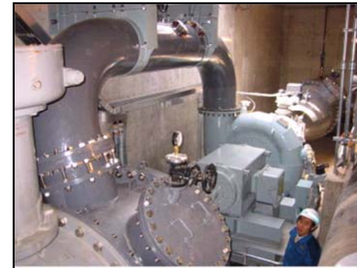
図 港北排水池小水力発電(上水道利用)
