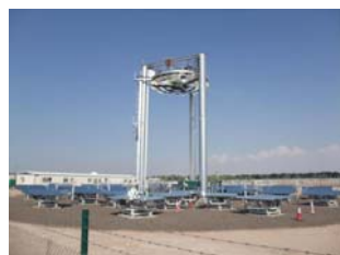
図 ビームダウン型太陽熱発電システム (アブダビ実証試験サイト)
