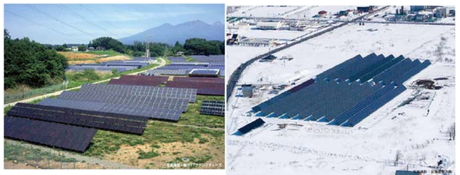
メガソーラー発電所
