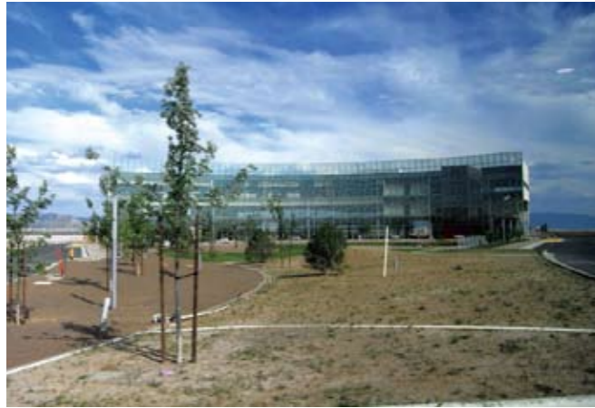
メサデルソールセンタービル(アルバカーキ実証サイト)
