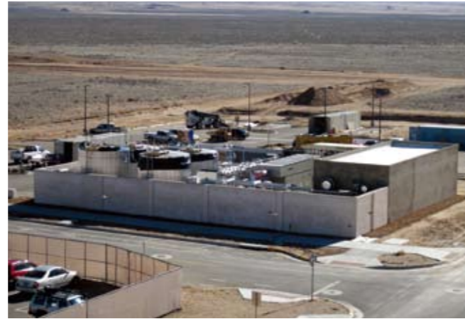
分散電源および蓄熱機器(アルバカーキ実証サイト)
