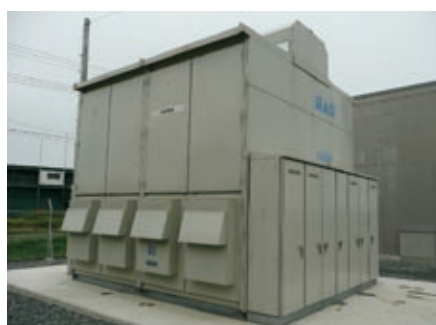
NAS電池システムの外観
