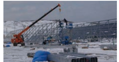
架台設置の様子
