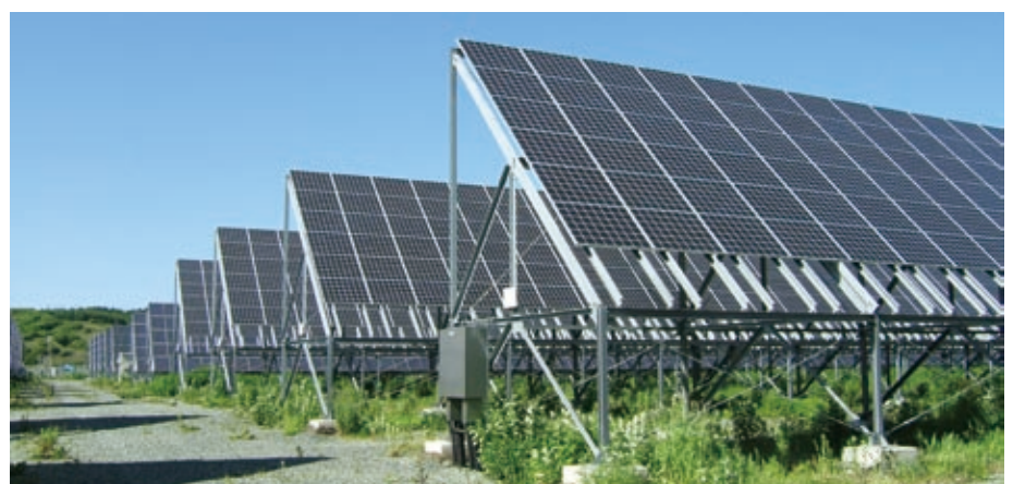
積雪対策として、PVモジュールの下端にパネル1枚程度のスペースを開けて設置されたPVアレイ(手前)
