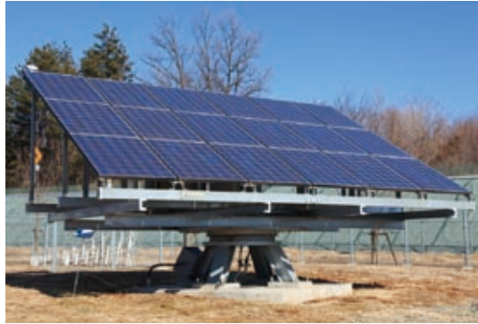
(左)1軸追尾システム：方位角(軸)を変化させ、水平に回転しながら太陽を追尾する。
