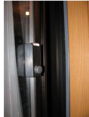
図 b-1-26(左図) 窓開閉ユニット
