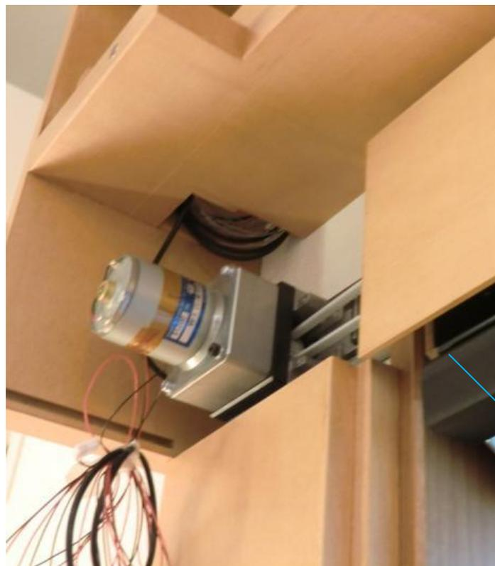
図 c-1-12-5 カーテンボックス内部と柱状カバーの取り付け部
