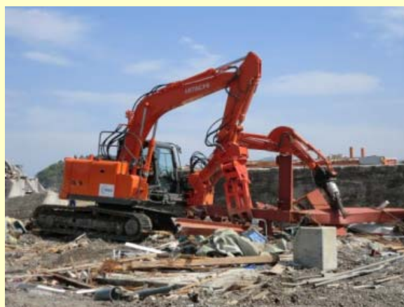
瓦礫撤去作業を行う「ASTACO NEO(アスタコネオ)」
