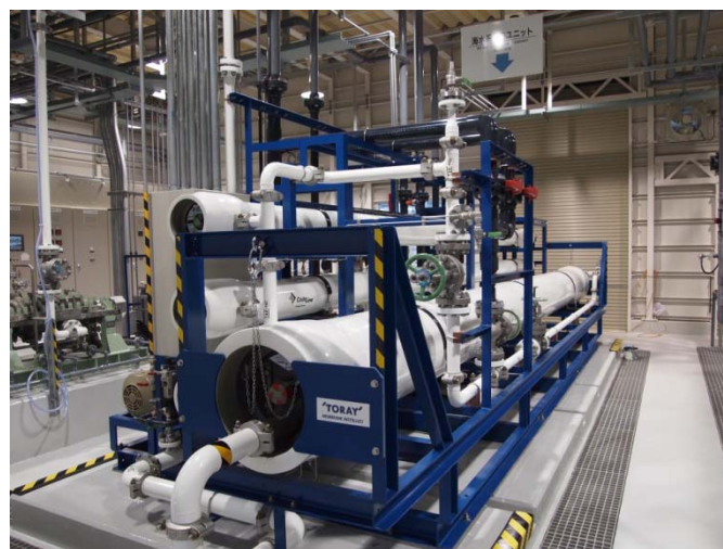
最新の16インチRO膜(ウォータープラザ北九州)
