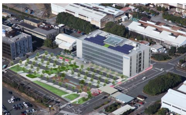
新日鉄エンジニアリング 「北九州技術センターE館」
