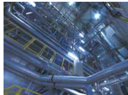
ストーカ炉を見上げたところ。無数のパイプが張りめぐらされ、燃焼効率向上や環境負荷低減の最新技術が組み込まれている。
