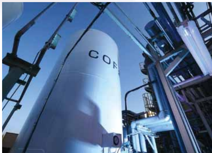
関東電化工業渋川工場のCOF 2 製造プラント
