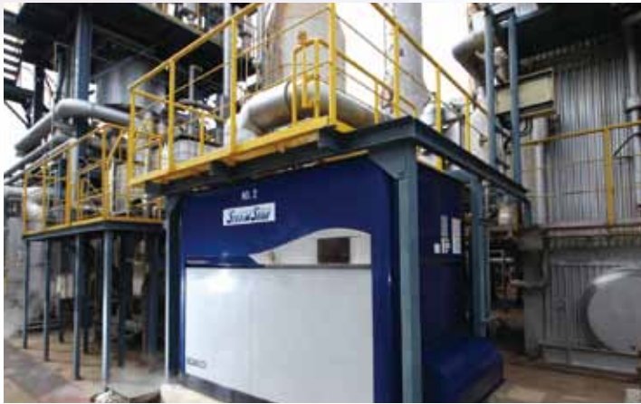
兵庫県尼崎市の蒸気製造プラントに設置された「スチームスター」設置スペース、工事費を低減できる小型設計。屋内外の設置が可能。
