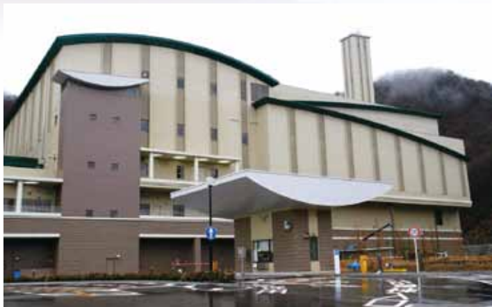
ハイパー21ストーカシステムが使われている国崎クリーンセンター合計2炉で1日235トンのごみ処理能力がある。蒸気の余熱は発電や温水にも利用される。
