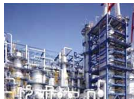
新触媒が使用されているコスモ石油の脱硫プラント
