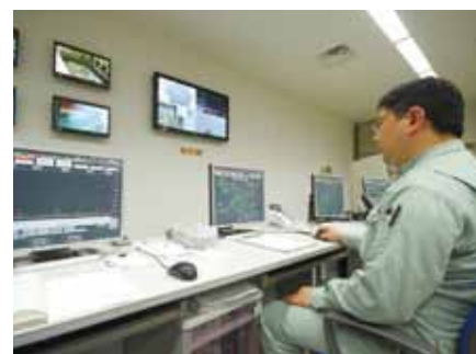
国崎クリーンセンターの制御管理室。モニターで炉内の様子も観察できる。
