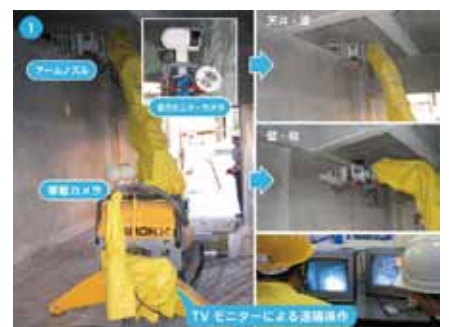
模擬アスベストの剥離と除去の実証実験の様子
