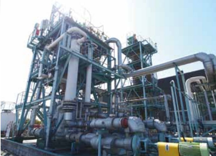
旭硝子にて稼働中の装置
