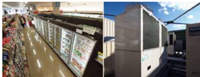
実証実験店： マックスバリュエクスプレス六郷土手駅前店。 (左)店舗内の冷凍ショーケース、 (右)店舗の屋上に設置されたノンフロン冷凍機
