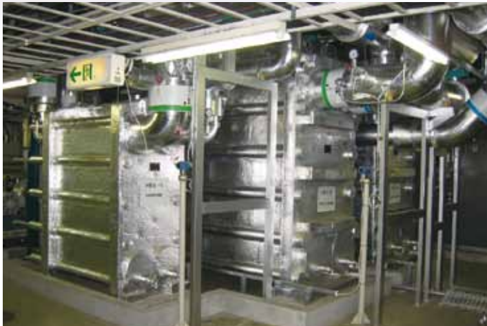
川崎駅地下街「アゼリア」の空調システムに取り付けられた水和物スラリの製造装置。
