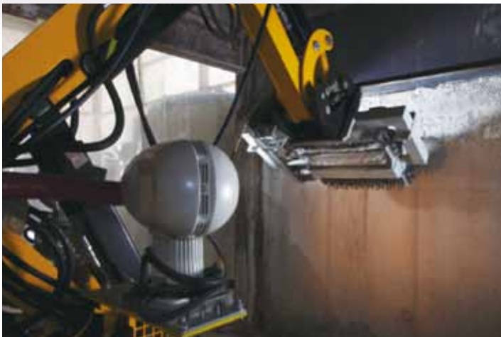
大成建設が開発した遠隔操作アスベスト除去ロボット (湿式フロア用)
