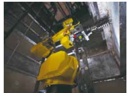
エレベーターシャフト用のアスベスト除去ロボット
