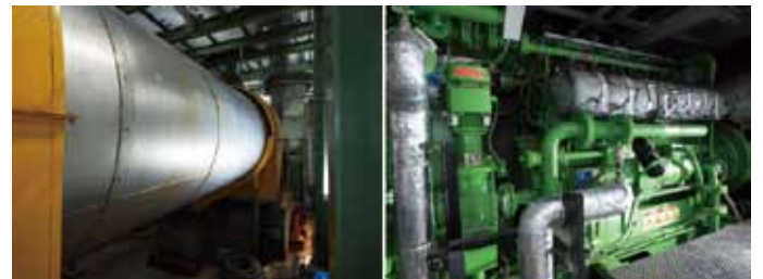
廃熱を利用した汚泥乾燥機 (左) と、ガスエンジン (右)
