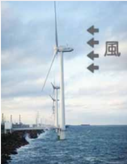
岸壁から50m離れた洋上に設置された2メガワット風車
