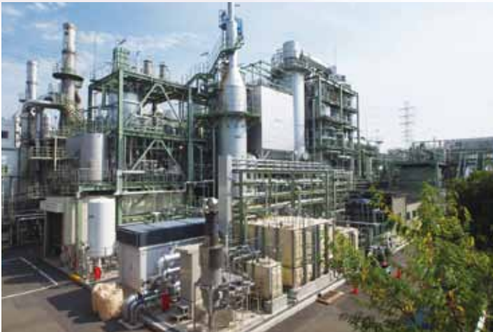
東京都下水道局清瀬水再生センターに設置された下水汚泥ガス化発電システム
