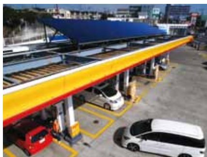
昭和シェル石油では、系列ガソリンスタンドへの太陽電池パネルの設置も進めている。節電効果だけでなく、災害時など停電時でも給油可能な点をアピールしている。
