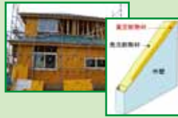
断熱性能25%向上住宅
