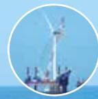
電源開発(株)では、すでに福井県のあわら北潟風力発電所でもギアレス機を採用していますが、今回のプロジェクトでは、洋上への設置を考慮して、塩分対策を重点的に行っているそうです。
