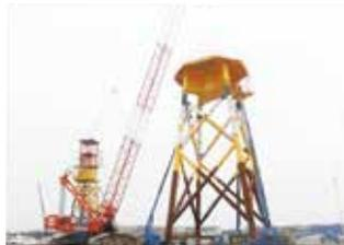
支持構造物は、コンクリートと鋼材を組み合わせた、ハイブリッド重力式を採用しました。この型式は、安定性と耐波浪性に優れています。
