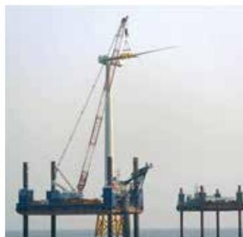
③風車設置(ブレード設置状況)
