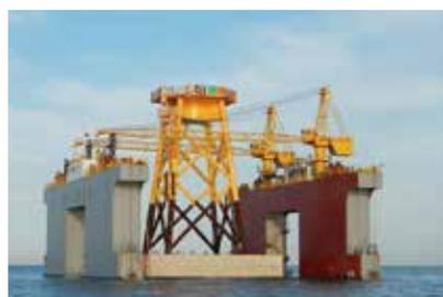
①フローティングドック上で製作された支持構造物の状況
