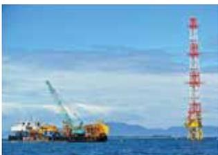
洋上風車で発電した電力を陸上へ送電したり、洋上風況観測タワーの計測装置に電源を供給する電力ケーブルと、観測データ等を送信する通信ケーブルを専用の作業船を用いて海底に敷設しています。
