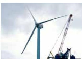
すべての設備の設置終了後、各設備の試運転を行い、発電設備、観測設備、通信設備などの点検を行います。特に風車の試運転では、電気系統、安全装置、ブレーキ、ピッチ制御などの動作確認を行います。
