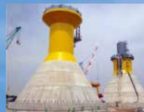
■ハイブリッド重力式：重力式の経済面の利点とジャケット式の構造安定性・施工性における利点も生かした構造です。（北九州市沖）
