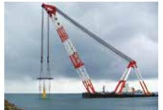
敷設した海底ケーブルを陸上に設置する開閉設備へ接続するために、陸上に近い海域部に、海上鉄柱を設置し架空でケーブルを接続します。
