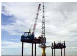
洋上約100mの鉄塔で、10m間隔で風向や風速などを計測します。最大200mまでの上空の風況をリモートセンシング技術で観測できる国内初の観測用のタワーです。
