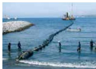
洋上風車で発電した電力を陸上に送電したり、洋上風況観測タワーの計器類に電源を供給する電力ケーブルと、観測結果や風車のデータを送信する通信ケーブルを海底に敷設しています。
