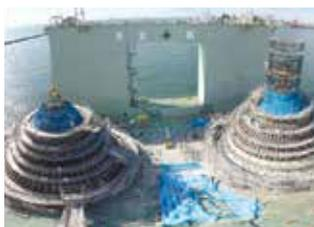
基礎構造物は、台風や地震などの厳しい自然環境下においても洋上風況観測タワーと洋上風車を支えるように設計・製作されたものです。海底から海面まで十数mの高さの構造物で重量は数千tです。
