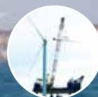
響をもろに受けるので、動揺の小さい船の真ん中から吊り下げて、波と波の間の距離が船体の長さ以下になり、船が安定する一瞬を狙ってケーソンを降ろしました。
