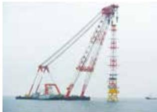
海面高さ約80mの観測タワーを、大型起重機船によって据付しました。10m間隔で風向・風速を計測します。
