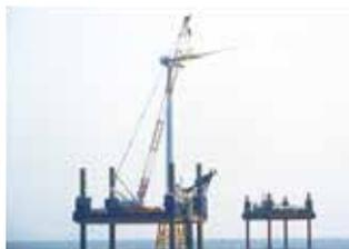
ブレードの中心は海面高さ約80m、ローター径83mで、1980kwの発電機、変圧器などが搭載されています。また、塩害対策など洋上ならではの対策も講じております。
