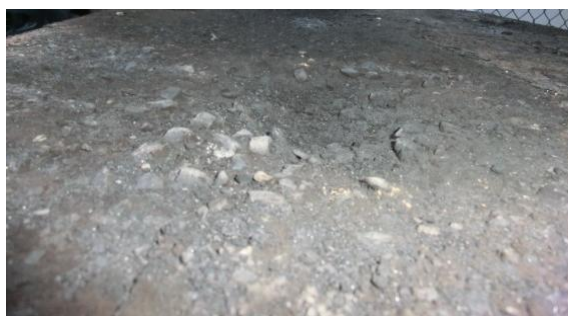
図15 アスファルト路面の損傷状況
