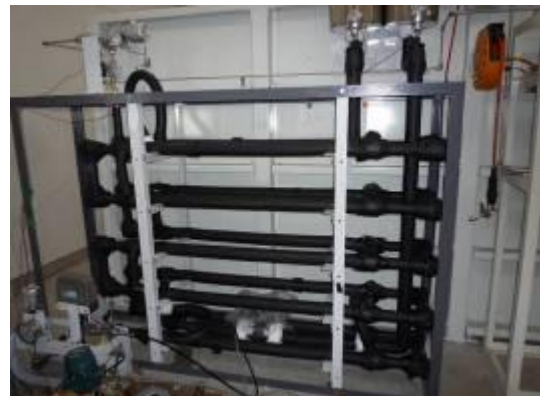
熱交換器（試験装置）
