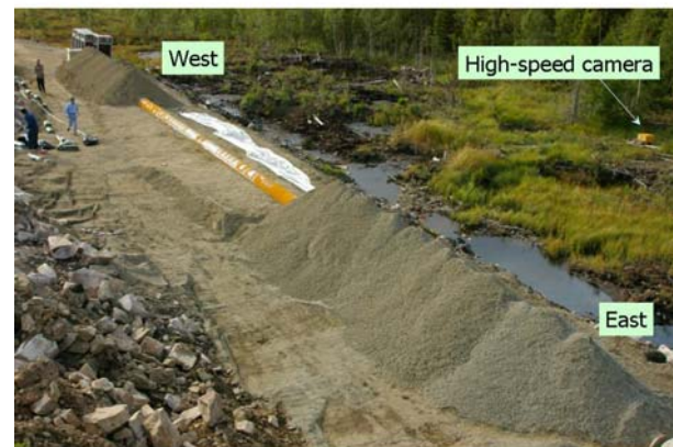
図 4 実大バースト試験体の設置状況
