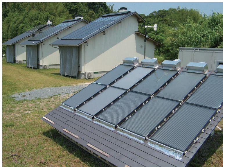
図2. [左奥]3つの実験棟[一般住宅, OM開発仕様, OM現行] [右手前]集熱実験
