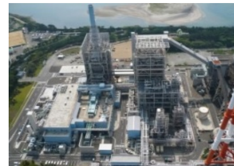
IGCC(ガス化発電) 25万kW 勿来:常磐火力10号機 三菱日立パワーシステムズ(株)
