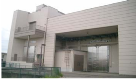
空調試験室の外観
