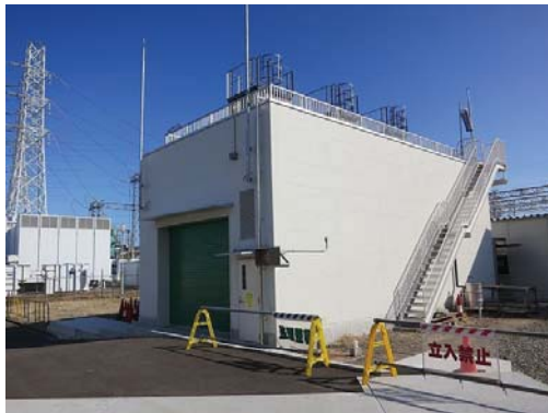
冷却システム建屋
