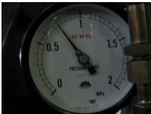
図 2.4.2-9 加圧直後の圧力計表示
