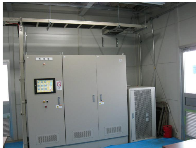
図 2.4.2-65 計測室内配線、ラック設置
