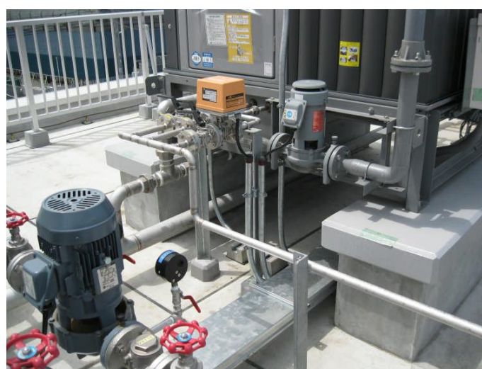
図 2.4.2-66 屋上配線、ラック、配管設置
