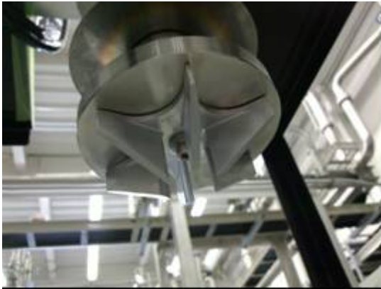
(a) ポンプ B 羽根状況
