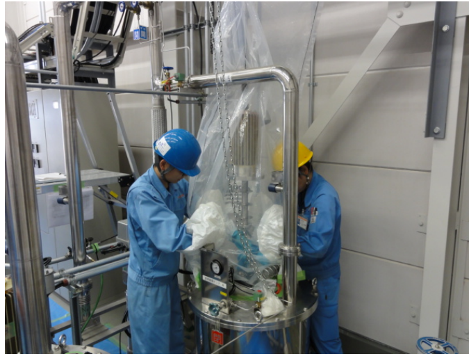
図 2.4.8-9 ポンプ取り外し中状態
