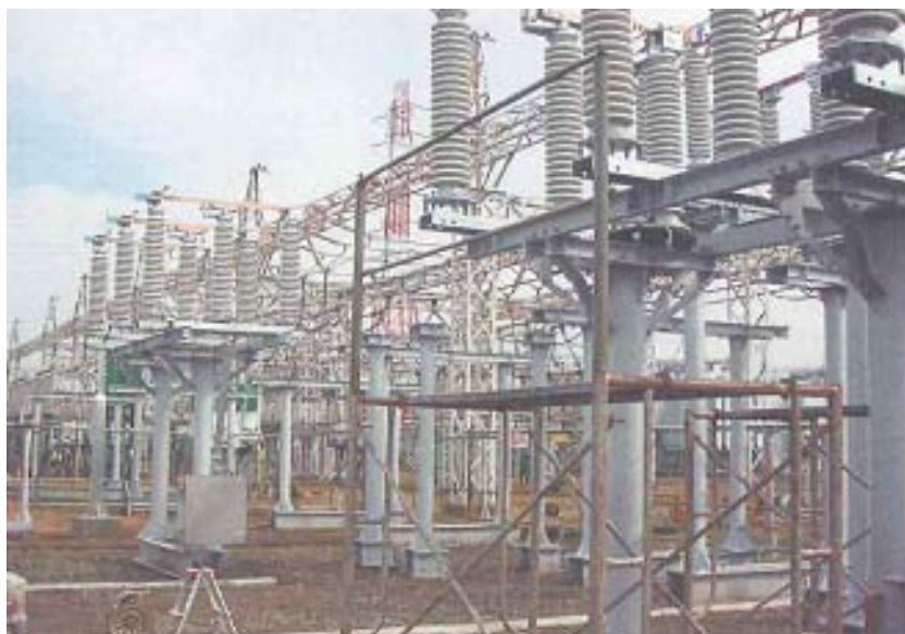
図 2.4.2-6 断路器 据え付け施工後
