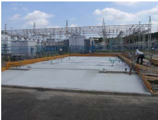
図 2.4.2-2 冷却システム建屋 （左）基礎コンクリート工事、（右）完成後
