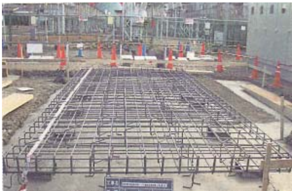
図 2.4.2-1 超電導ケーブル端末用（左）配筋出来形 （右）土間コンクリート
