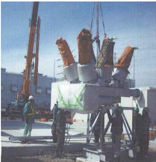
図 2.4.2-5 ガス遮断器（左）据え付け状況、（右）施工後
