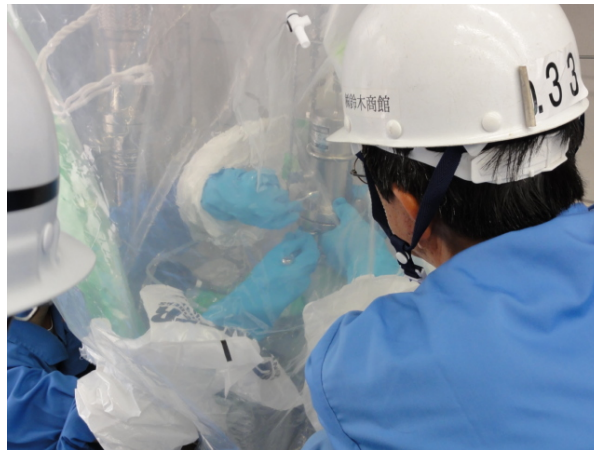
図 2.4.8-11 フィルタ取り外し時状況
