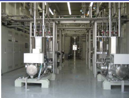
冷却システム外観
