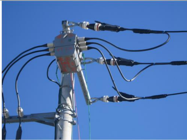
図 2. 4. 2-21 PAS 設置 (敷地外の 6kV から PAS への配線除く)
