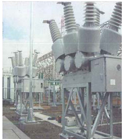
図 2.4.2-5 ガス遮断器（左）据え付け状況、（右）施工後
