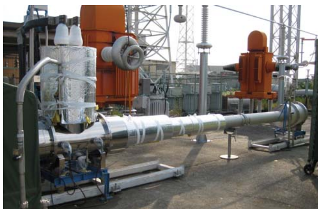
図 2.1.3-6 中間接続部 過冷却通電試験状況
