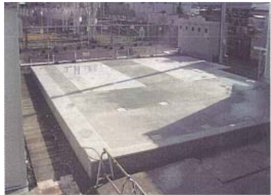
図 2.4.2-1 超電導ケーブル端末用（左）配筋出来形 （右）土間コンクリート
