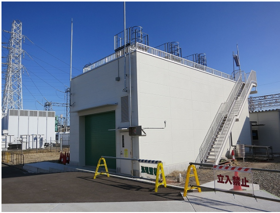
冷却システム建屋
