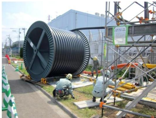
図 2.4.2-38 ケーブル布設状況（アンダーローラー側）
