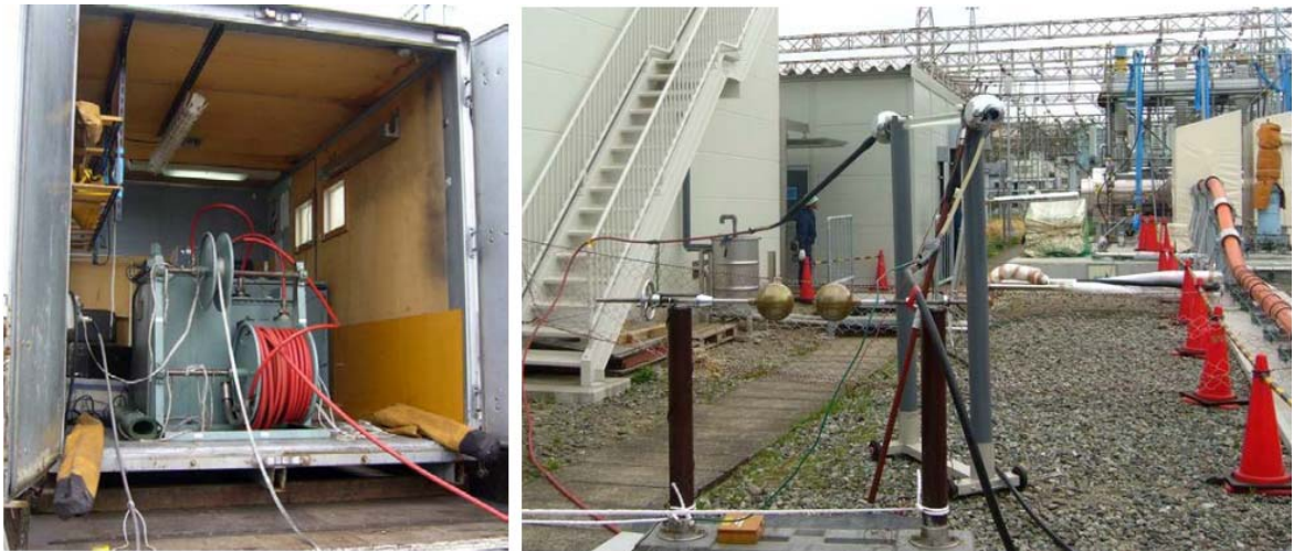
図 2.4.7-3 DC 課電試験実施状況
