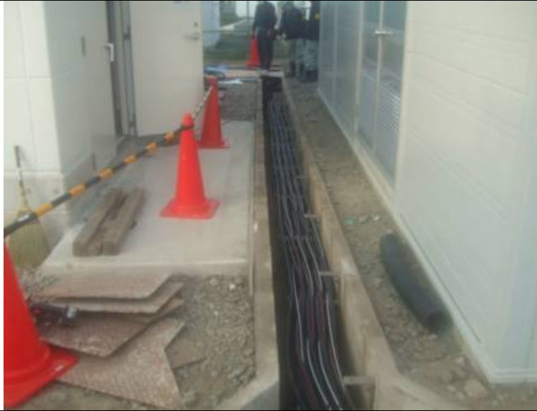
図 2.4.2-27 各分電盤までの配線 状況 (冷却システム室 と計測室の間)
