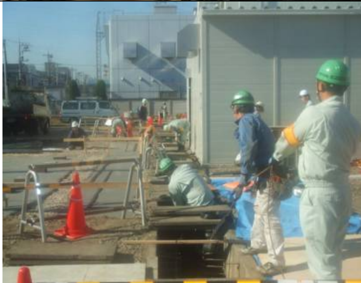
図 2.4.2-26 各分電盤までの配線 状況 (冷却システム室 南側)
