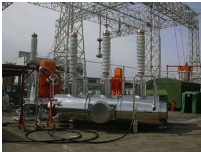
図 2.1.4-15 終端接続部単体試験状況
