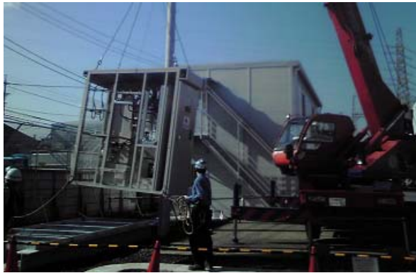
図 2.4.2-3 試験用キュービクル (左) 据付様子、(右) 完成後
