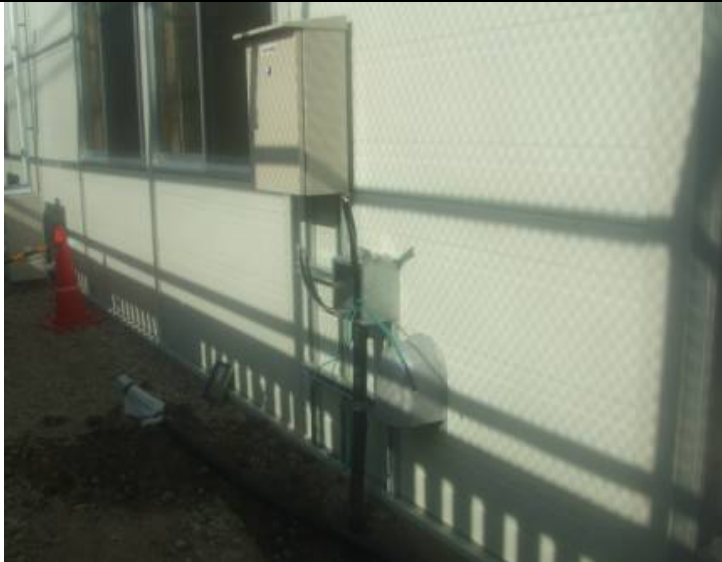
図 2. 4. 2-22 工事事務所分電盤
