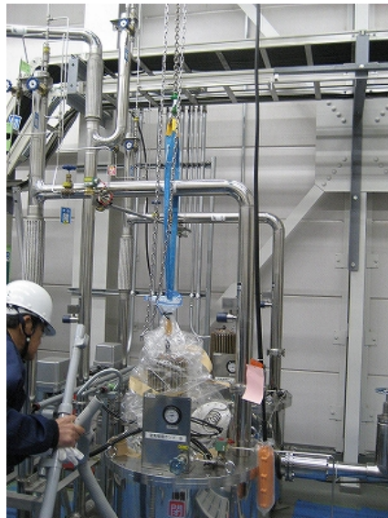
図 2.4.5-17 循環ポンプメンテナンス中ポンプ周り状態
