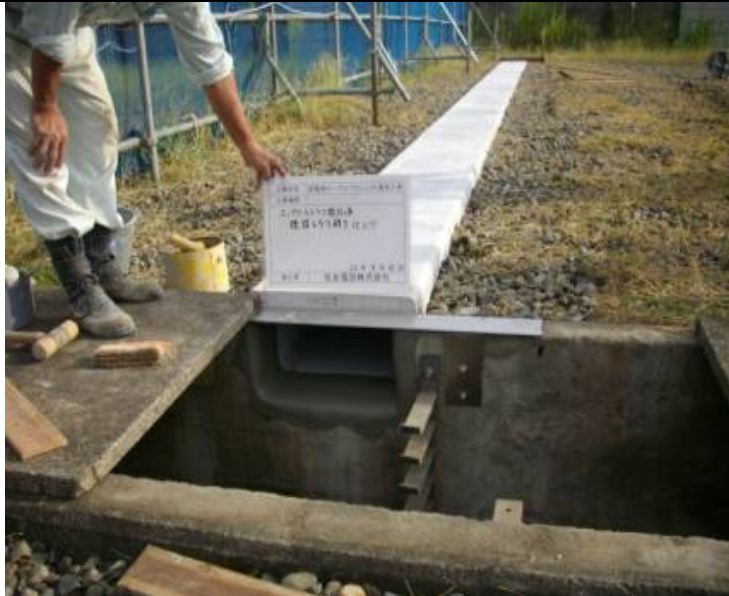
図 2.4.2-25 冷却システムーキュー ービクル間トラフ
