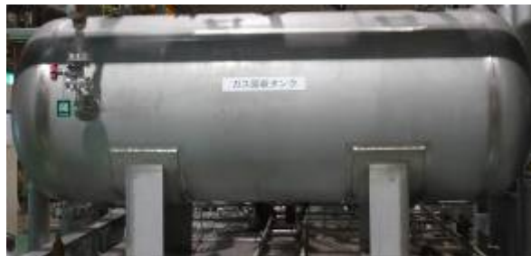
図 2.6.4-4 バッファタンク
