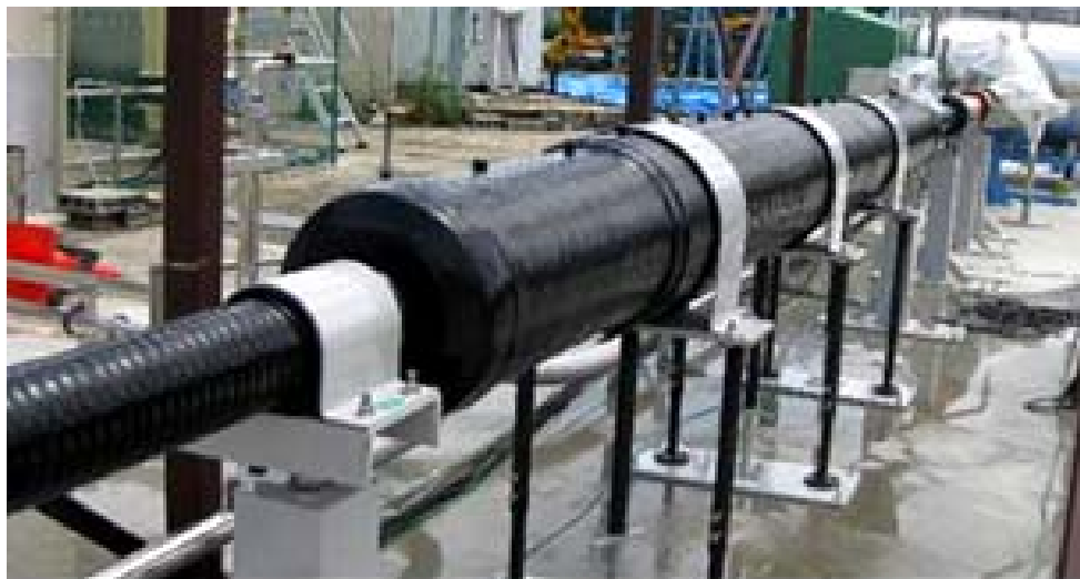
(e) 防食層施工後
