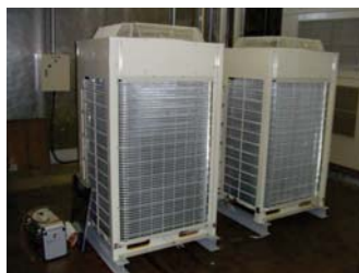
室外機 (冷暖同時機)
