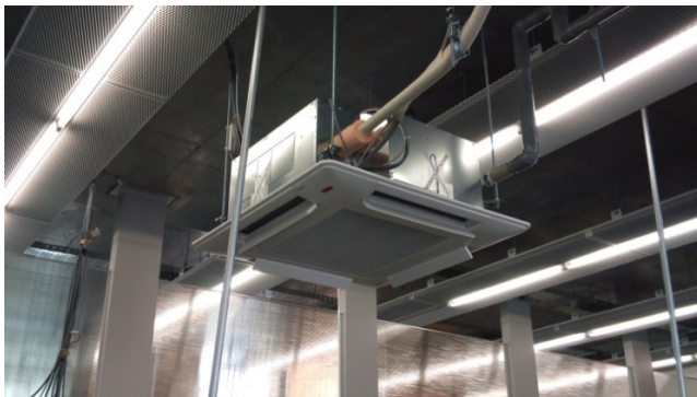
札幌 開発システム 室外機
