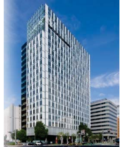
実証試験ビル外観 階数: 地上19階、地下3階 延床面積: 約37,000㎡
