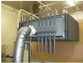
室内機の外観
