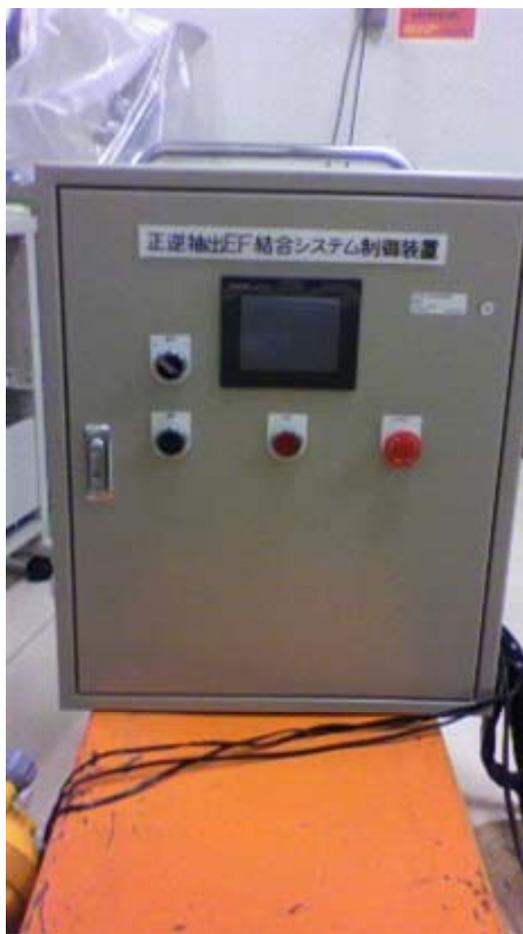
図Ⅲ. 2. 6. 1-94 正抽出・逆抽出同時進行システムについての電子制御盤
