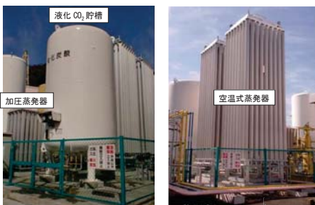
受託研究で追設したCO 2 供給設備
