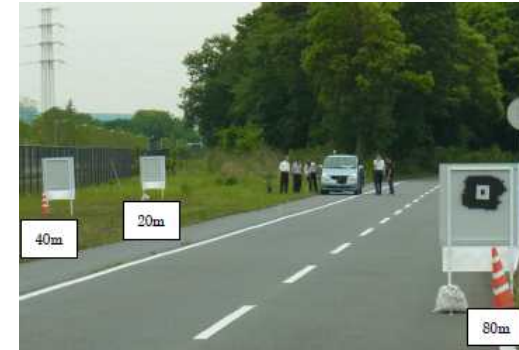
実際のシステム調整作業の様子
