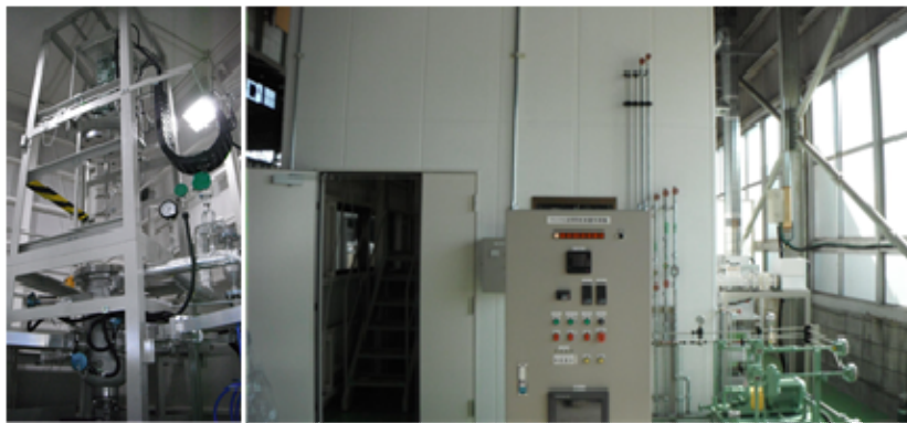
図Ⅲ-2.2.2-15 溶剤型マイクロ波設備
