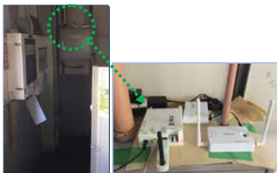
図 - (4)-5-1-3.1a GCON 接続検証 ( フィールド設置状況 )
