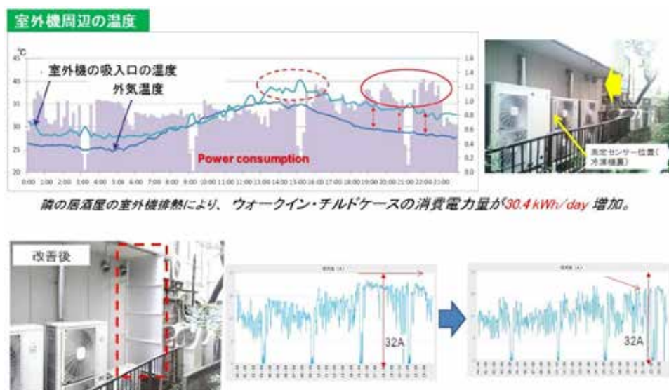
図 - (1)-3-3.3 “低効率”：冷蔵・冷凍機の室外機環境
