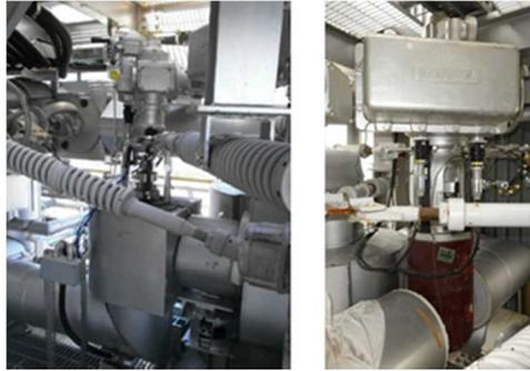
図 47 一般弁（玉型弁）
