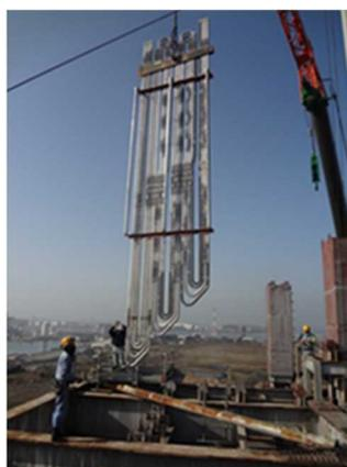
図 43 700°C級過熱器 (ボイラへの組込み)
