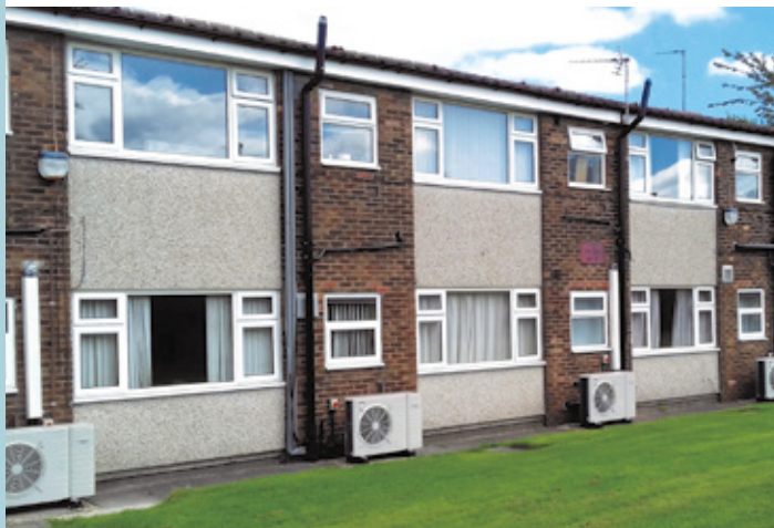
ヒートポンプが設置された住宅外観 (英国・マンチェスター) Wigan & Leigh Homes 管理物件 Daikin Airconditioning UK Limited, (2016年11月)
