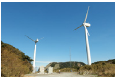
阿土山風力発電所
