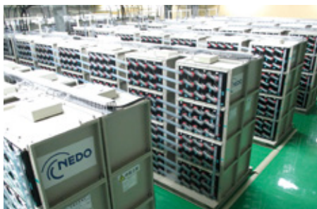
鉛蓄電池-LIC ハイブリッド型蓄電システム(伊豆大島)
