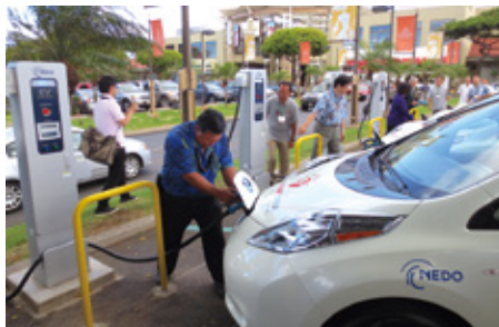
EV急速充電ステーション
