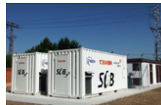
リチウムイオン電池を搭載した可搬式蓄電池システム(スペイン)
