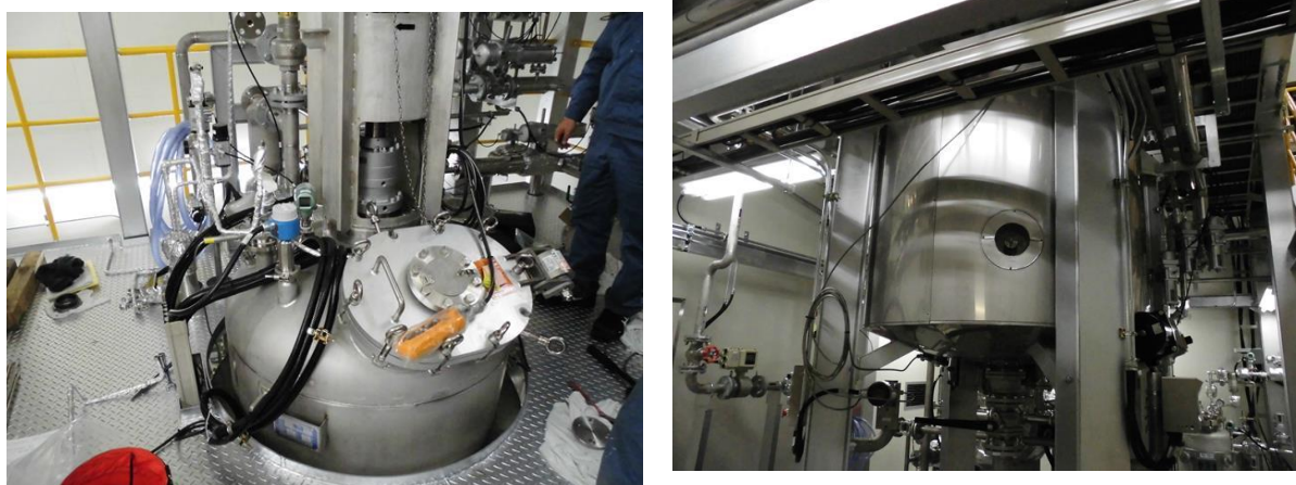
図 2.4.3-16 2 m 3 パイロット同時糖化発酵装置（産総研 中国センター設置）
