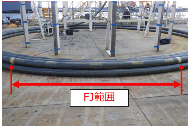
図 3-5-12 工場ジョイント外観
