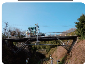
点検車が載らない橋
