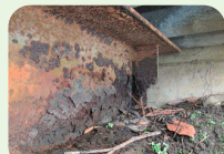
点検障害物(土砂・劣化塗膜等)
