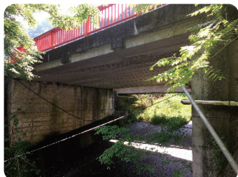
コンクリート床版橋
