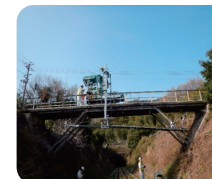
水平アーム上の点検ユニット の交換が効率阻害
