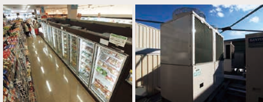
実証実験店： マックスバリュエクスプレ 六郷土手駅前店 (左) 店舗内の冷凍ショーケース、 (右) 店舗の屋上に設置されたノンフロン冷凍機。
