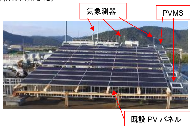
図 III-2-(ホ)-2-④-1 PVMS の設置状況。東西、南北方向にそれぞれ 6 つの PVMS を 1.145 m 間隔で配置。
