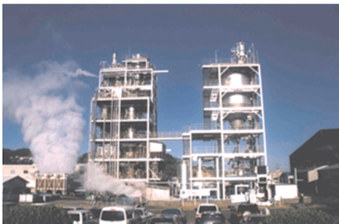
図 3-1.2 50TPD ガス化炉試験設備
