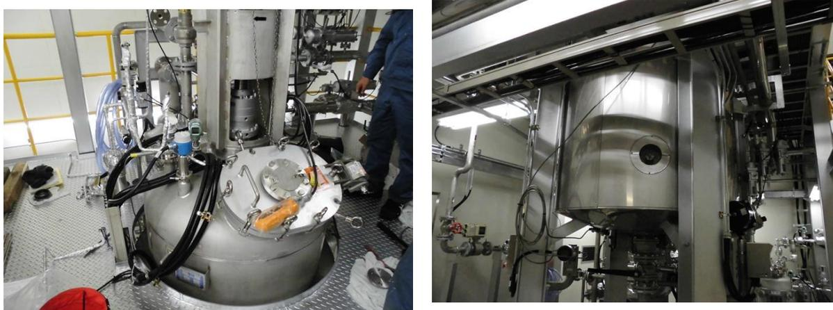
図 2.4.3-16 2 m<sup>3</sup>パイロット同時糖化発酵装置（産総研 中国センター設置）
