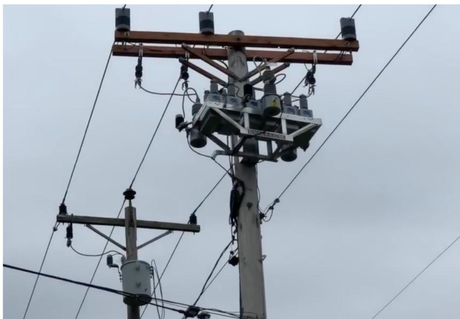
図 5.3.1-2 配電柱上の Advanced Switching Capacitor<sup>[4]</sup>
