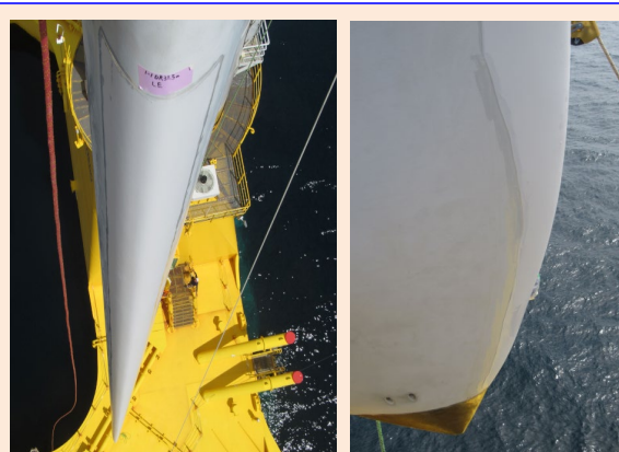
エロージョンテープ張替え後 (8/1完了時)
