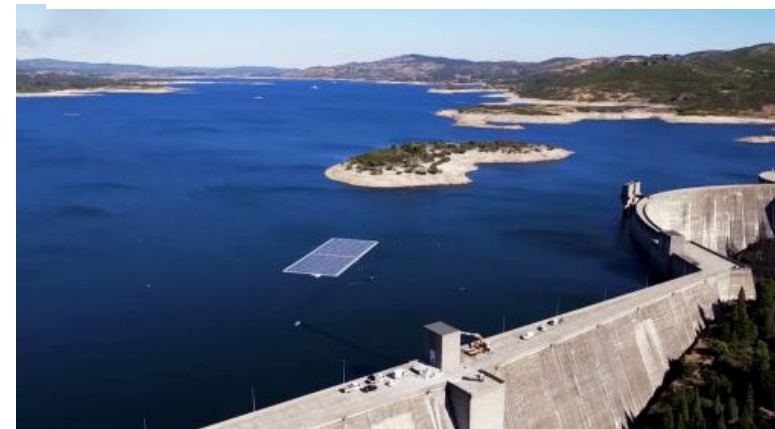
世界初の水力発電・FPVのハイブリッドシステム (PV=220kW、ポルトガル・Alto Rabagaoダム)
