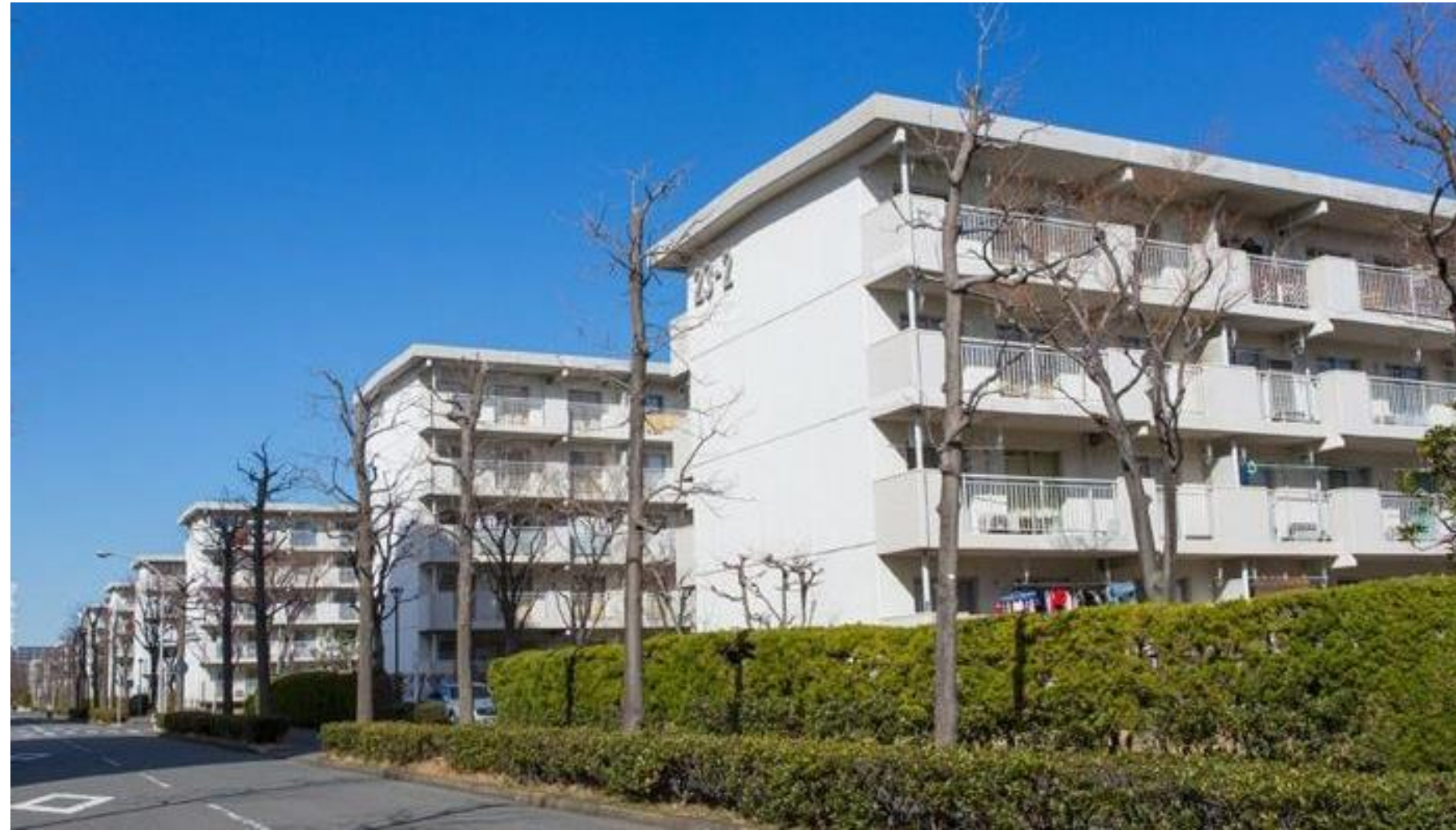
「金沢シーサイドタウン並木一丁目第二団地」 （神奈川県横浜市金沢区）
