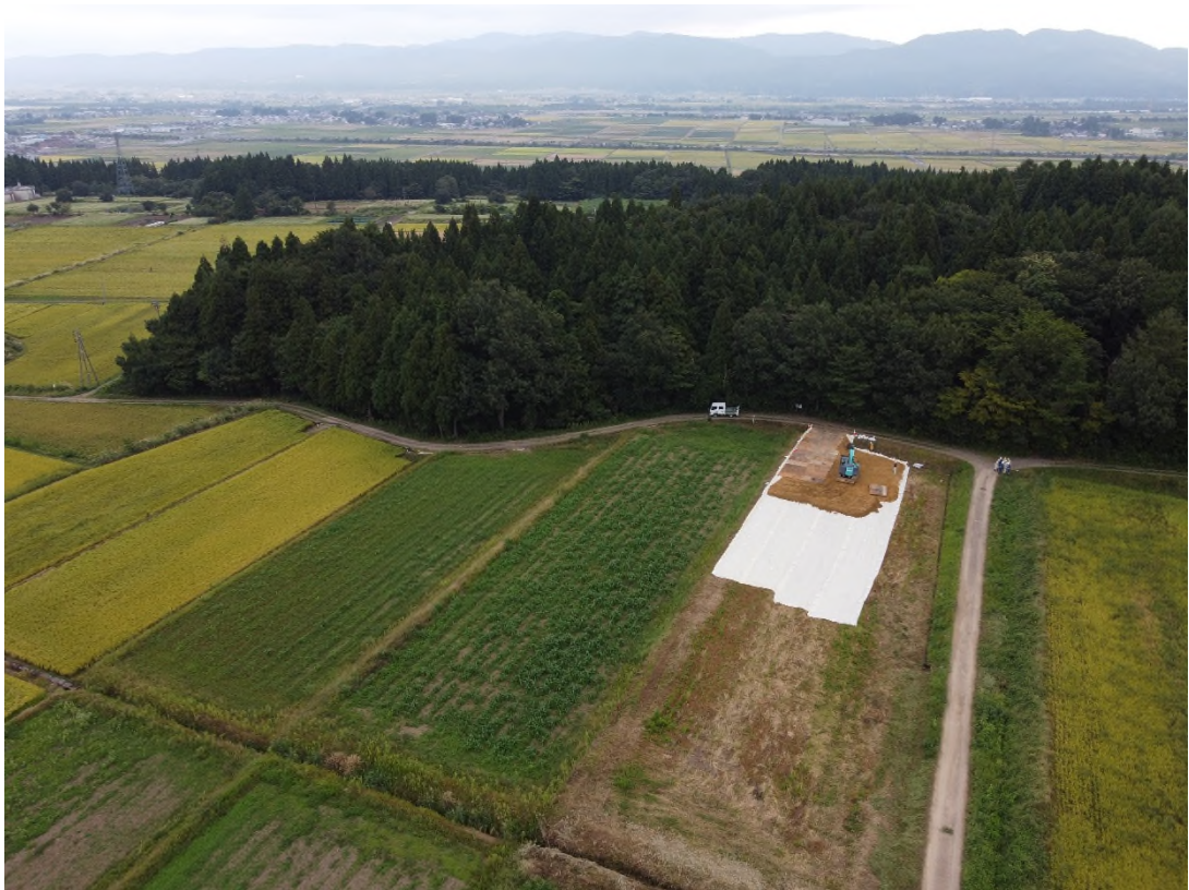
図 2-10 400 Nm 3 /h 試験設備建設地着工直後の様子 (2022年9月撮影)
