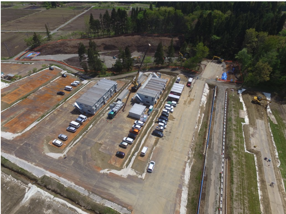
図 2-11 400 Nm 3 /h 試験設備建設地造成工事中の様子 (2023年4月撮影)
