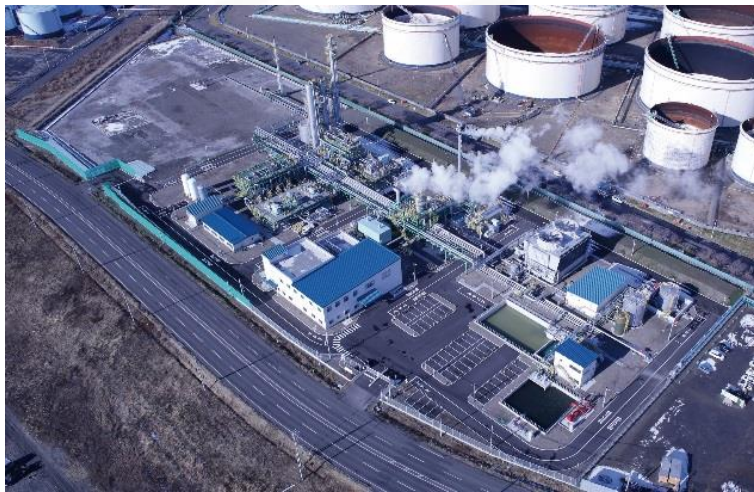
苫小牧CCS実証試験センター
