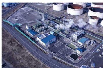
苫小牧CCS実証試験センター
