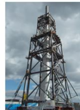
タワージャッキダウン 解体工法
