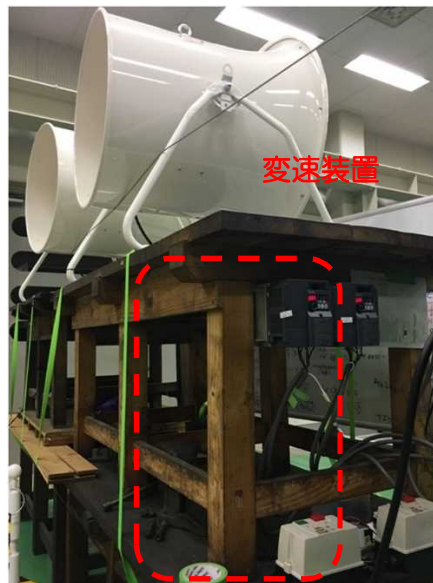
図 2.1.1.7-143 送風機と変速装置
