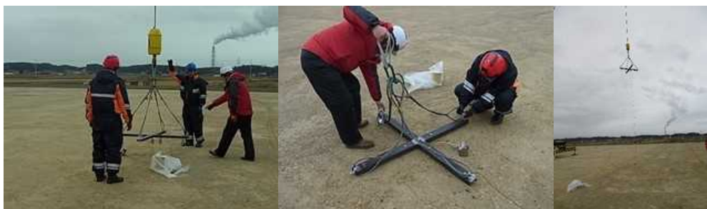
図 2. 1. 1. 7-25 クレーンによる落下準備
