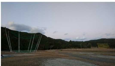
図 2.1.1.7-207 ホーベック鳥羽工場に設置された 大型無人航空機落下受止装置（左）と無人航空機用落下受止装置（水平飛行からの落下受止装置）（右）
