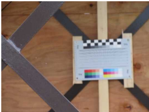
図 2.1.1.2-39 トラス越しの撮影例 (手前のトラスにピントが合った場合)
