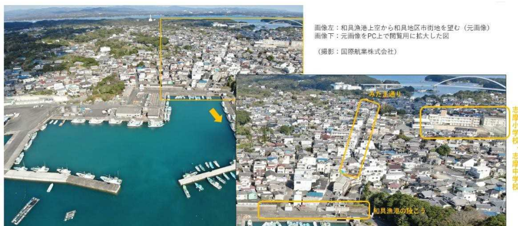
図 2.2.1.14-160 ドローンにより取得した斜め撮影画像の例
