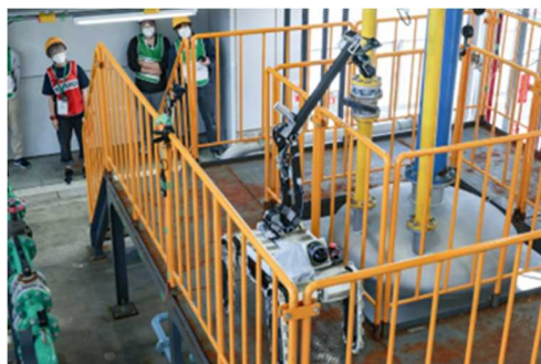
写真3 狭い空間でのバルブ操作
