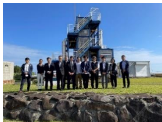
海洋温度差発電実証機(100kW)
